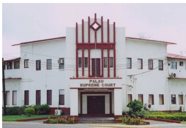
写真 2 パラオ最高裁判所 （旧南洋庁パラオ支庁）の現況
