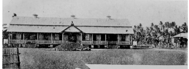
写真10 マキ公学校校舎
