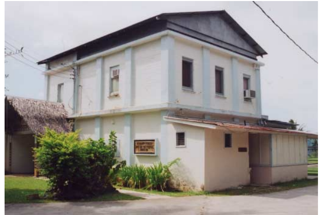
写真6 ペラウ国立博物館（旧南洋庁観測所（旧庁舎））の現況
