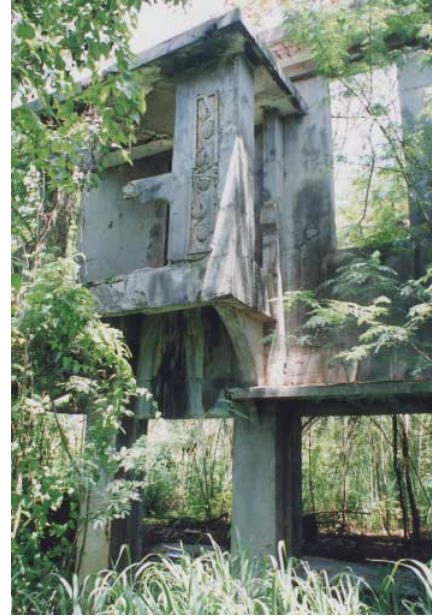
写真 17 旧南洋興発テナン製糖所 糖度分析棟の現況
