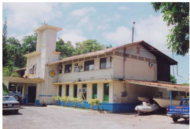
写真8 社会文化省分館（旧南洋庁気象台（新庁舎））の現況
